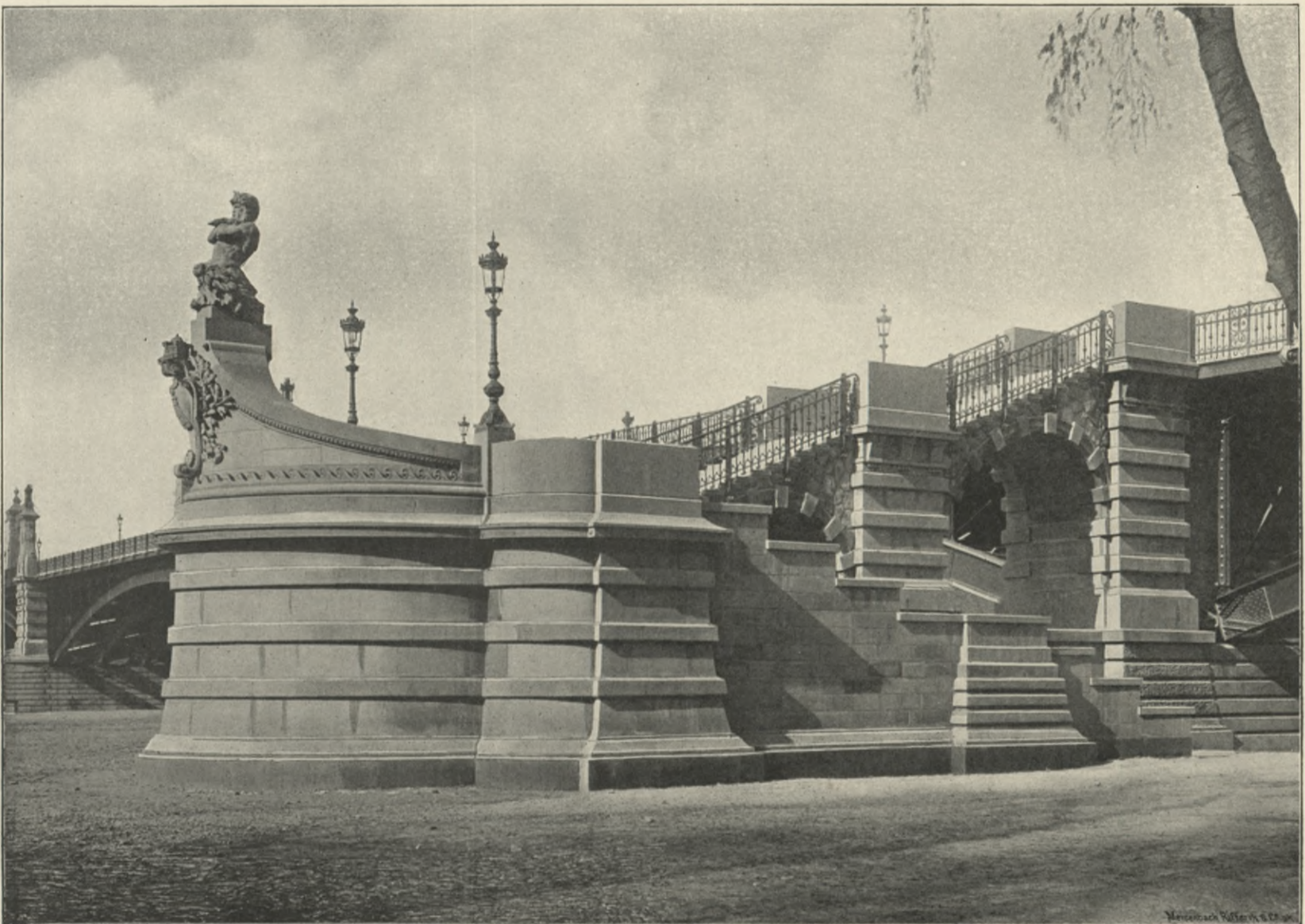
Treppenanlage auf dem rechten Vorland.
