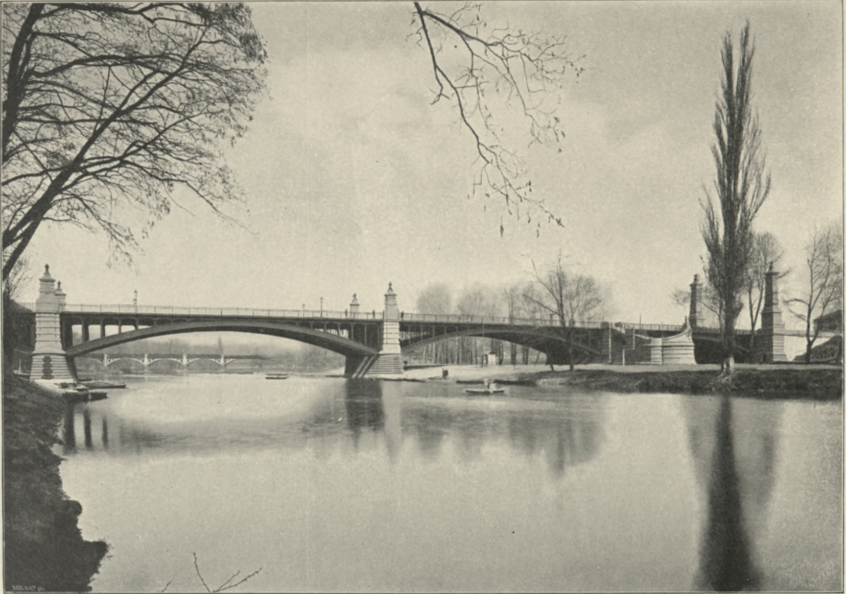
Ansicht der Brücke vom Neckar aus.
