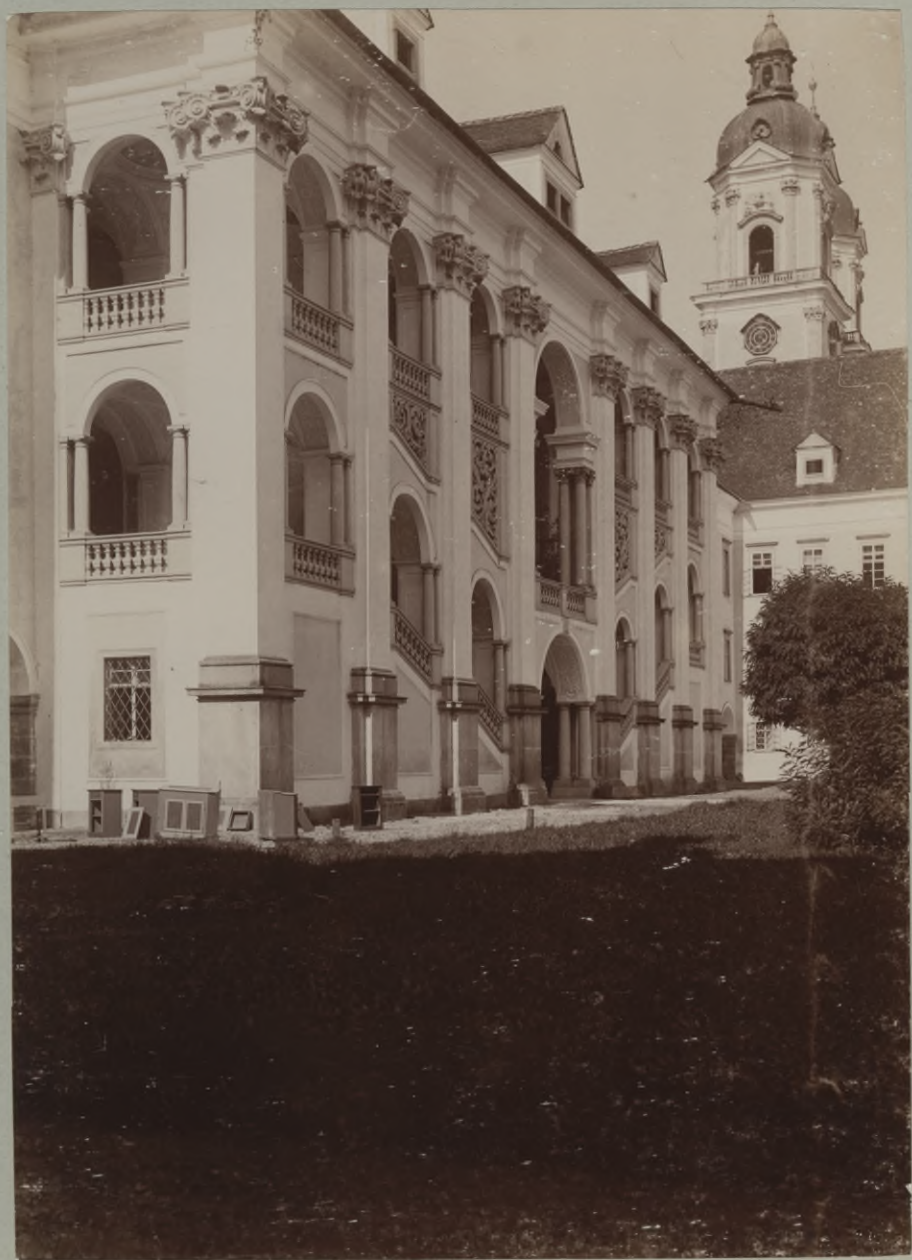
St. Florian. Treppenhaus u. Thurm.
