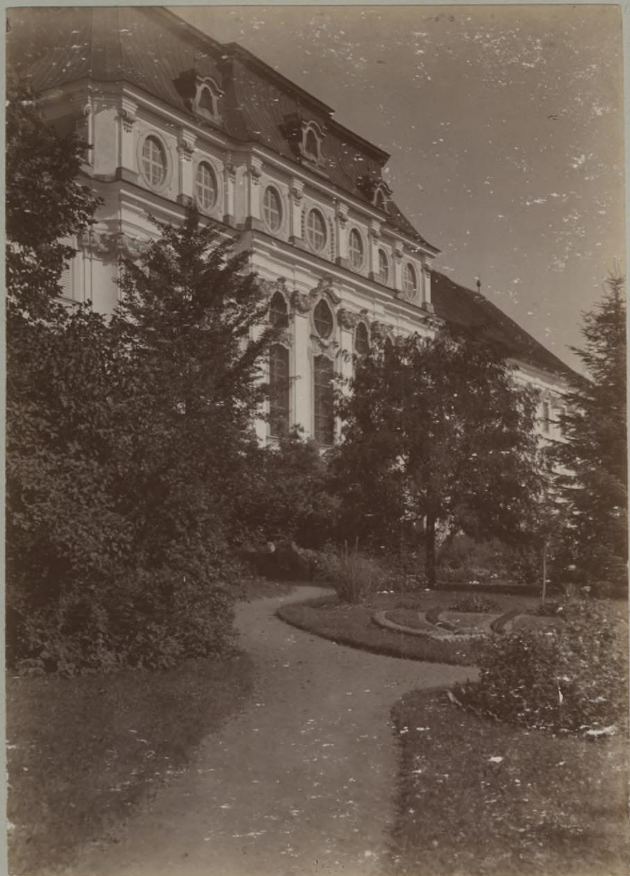
St. Florian. Südfront, Mittelbau.
